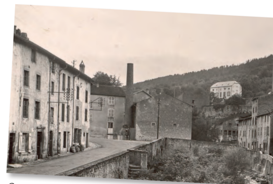
Carte postale : le ruisseau de Montenach et l'ancien moulin Bourger (date illisible) Faute d'eau, ce moulin fonctionnait à vapeur, d'où la présence d'une cheminée.
