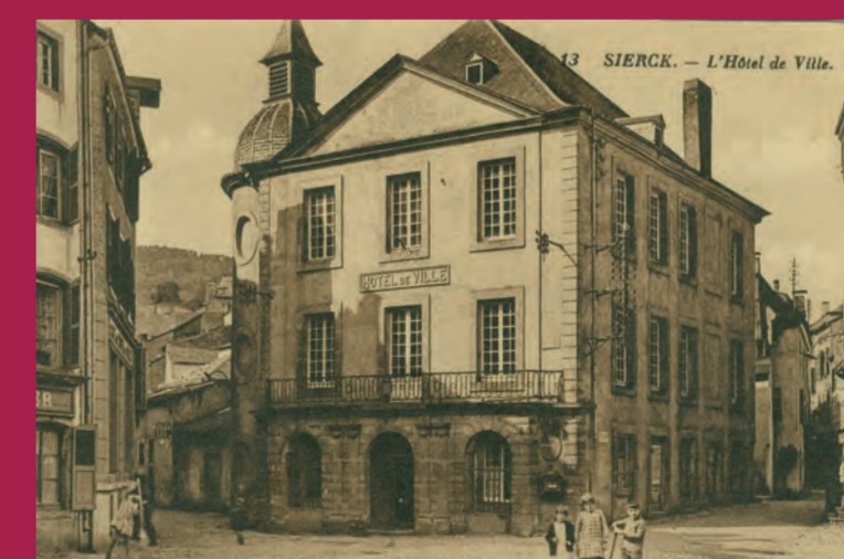
Carte postale : ancien Hôtel de ville, angle Grand'rue / rue du Moulin (date illisible)
