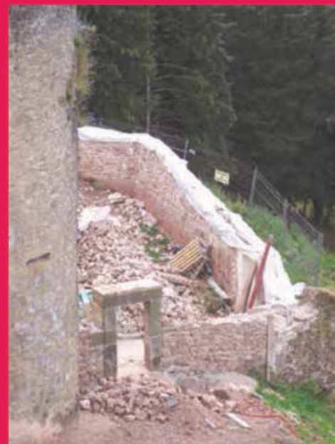
RESTAURATION DE LA COURTINE EST DU CHÂTEAU DES DUCS DE LORRAINE SIERCK-LES-BAINS (MOSELLE)
